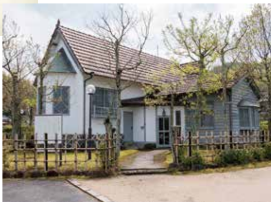
少年山荘(夢二郷土美術館 分館) 関東大震災の翌年大正13年東京都荏原郡に 洋風アトリエ付き住宅「少年山荘」を建設 昭和54年 夢二の生家の近くに復元されて現存している
